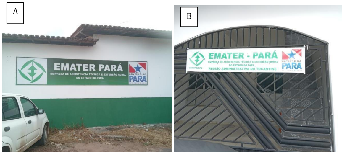
Figura 2 - Fachada do Escritório Local da Emater em Abaetetuba (A) e fachada da Emater- PA Regional Tocantins, sediadas em Abaetetuba (B)
