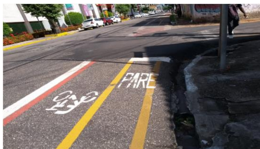
Figura 44: Sinalização sobreposta e fora dos padrões da norma
