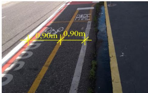
Figura 30: Espaço útil irregular no trecho 02.
