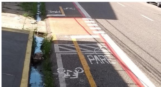
Figura 46: sinalização horizontal sobreposta
