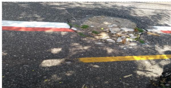
Figura 35: Buraco na sinalização, onde faz a divisão entre as faixas de rodagem e a ciclofaixa.
