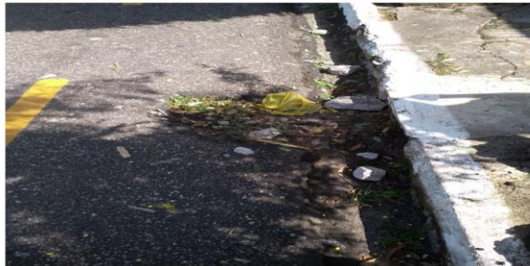
Figura 35: Buraco na sinalização, onde faz a divisão entre as faixas de rodagem e a ciclofaixa.
