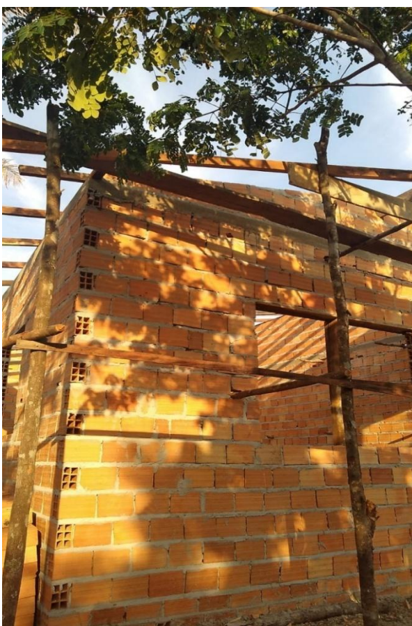
Figura 3 – Residência da família em construção.
