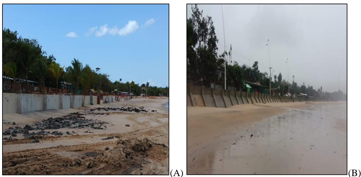
Figura 10- Processo de construção da Orla do Marahú e muro de arrimo (A). Orla e muro construídos (B). Fotografias retiradas em: 30/06/2018 e 08/12/2018, respectivamente. Fonte: Do autor.
