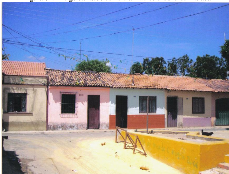
Figura 02: Antigo barracão comercial núcleo urbano de Marabá
