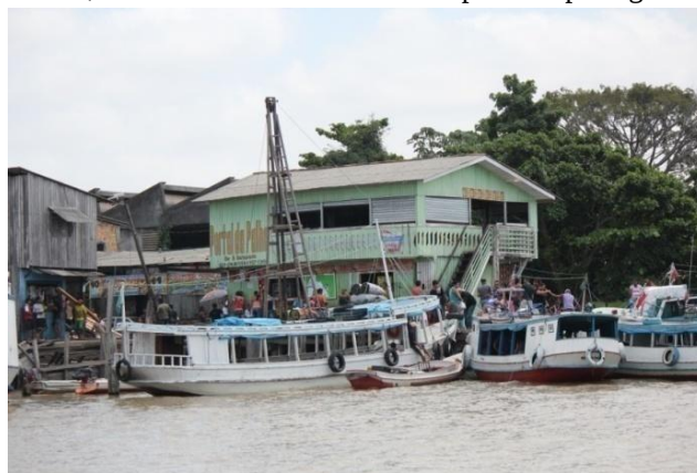
Figura 20 - Porto da Palha, terminal hidroviário com transporte de passageiros e produtos.
