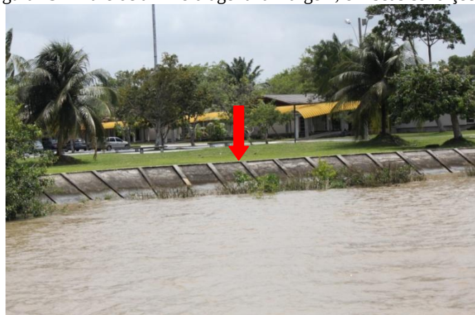
Figura 29 - Muro de arrimo diagonal a margem, em boas condições.
