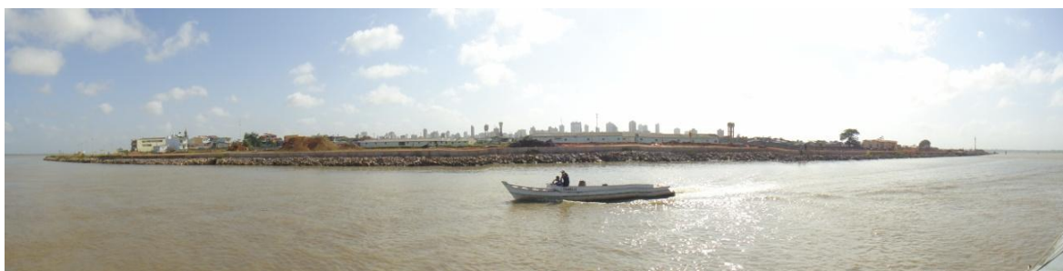
Figura 23 - Início das obras do projeto Portal da Amazônia.
