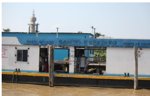
Figura 17 - Posto de combustível flutuante.
