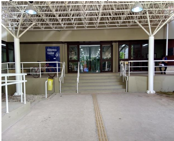
Figura 13: Biblioteca Central após a reforma, 2017.
