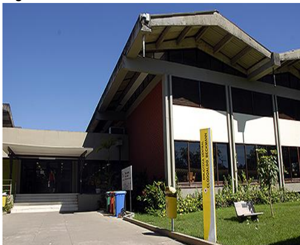
Figura 12: Biblioteca Central antes da reforma
