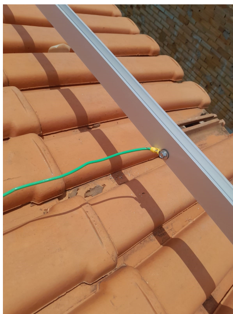
Figura 8 – Instalação de aterramento
