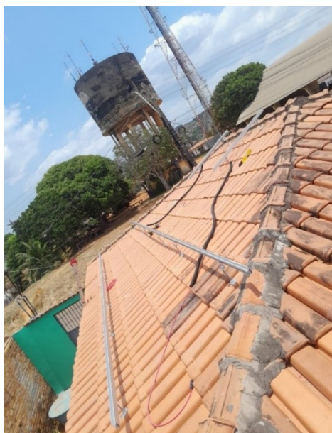
Figura 7 – Estrutura do telhado
