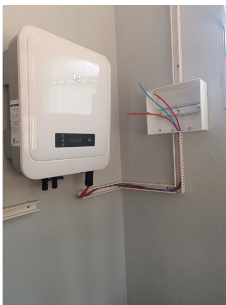
Figura 13 – Instalação da string box
