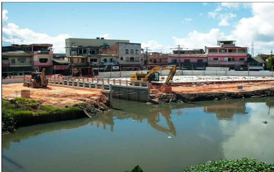
Figura 9 - A região do Lago Verde recebendo as obras de macrodrenagem
