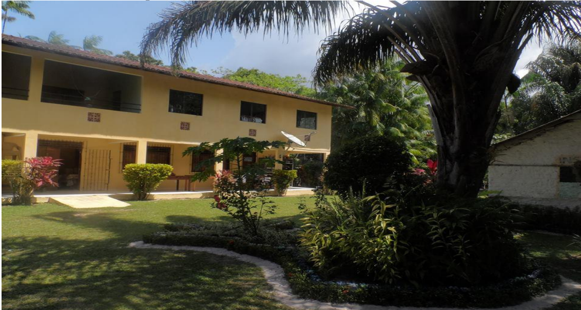
Figura 8 - Instituto Ampliar - lateral
