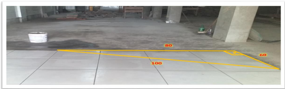
Figura 19: O uso do esquadro no assentamento de cerâmica em piso.
