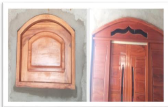
Figura 25: arcos em balancinho e janela na construção civil
