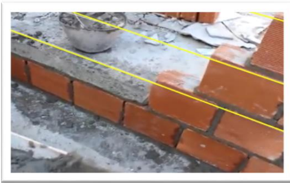
Figura 33: A linha de nylon no assentamento de tijolos em parede formando retas paralelas
