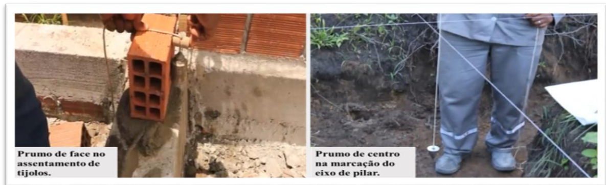
Figura 8: O uso do prumo de face e o prumo de centro
