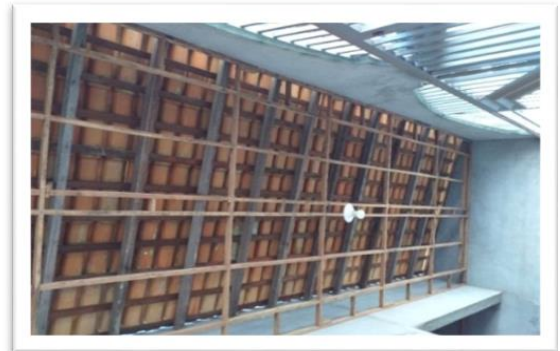
Figura 34: Estrutura de madeira para forro formando retas paralelas
