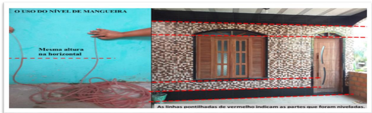
Figura 15: Aplicação da lei de Stevin na medida de uma altura de uma parede.
