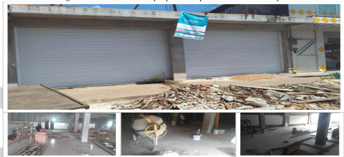
Figura 40: Prédio do local da pesquisa e sua parte interior em construção
