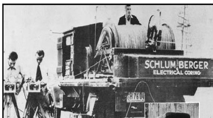
Figura 01- Imagem do equipamento original de perfilagem geofísica utilizado pelos irmãos Schlumberger em 1920.
