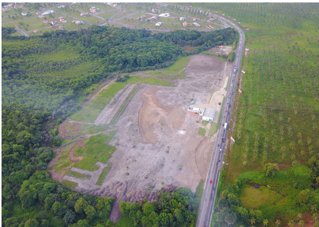
Figura 6 - Imagem aérea do canteiro de obras do Aqualand Resort.
