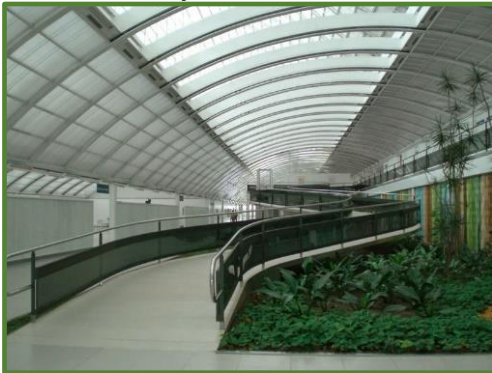
Figura 72 – Iluminação natural, jardim interno.
