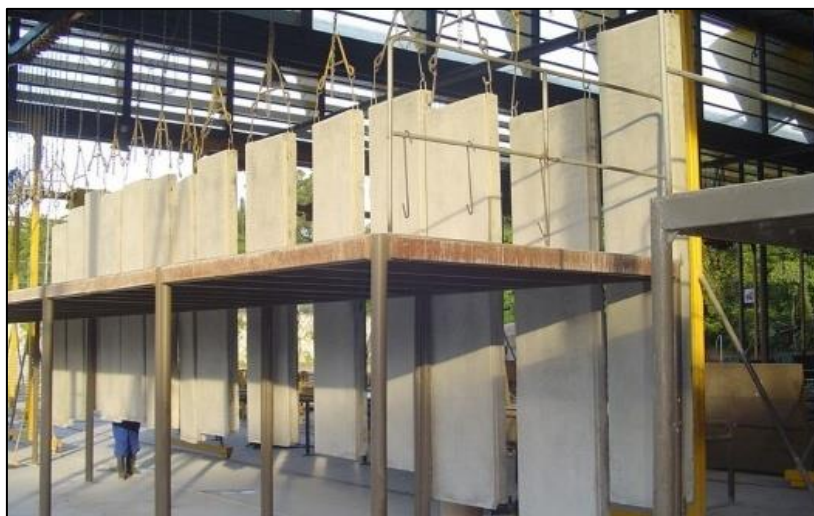
Figura 26 - Painéis de argamassa armada
