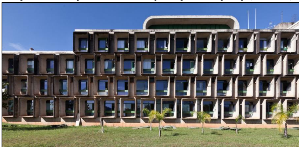
Figura 24 - Foto de parte da fachada do Hospital Regional de Taguatinga (Brasília/DF)
