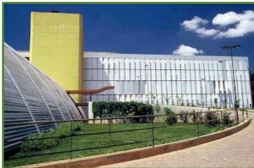
Figura 49 - Fachada ventilada com brises móveis
