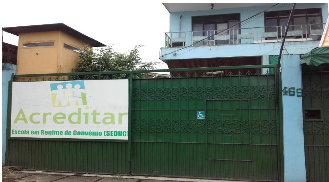
Fotografia 5 – Fachada da Associação Beneficente Milton Pereira de Melo
