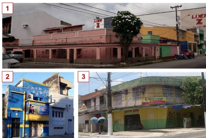
Figura 45: 1 - conjunto de casas com tendência modernizante localizadas na Rua Ângelo Custódio; 2 - duas edificações de mesma tendência localizadas na Av. 16 de Novembro; 3- ponto comercial localizado na Rua Cesário Alvim. Fonte: Sidney Pery, 2019.
