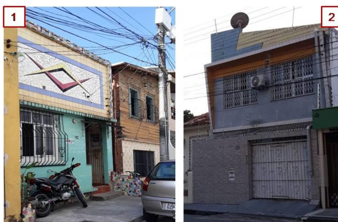
Figura 48: 1 – casa com estética Raio que o Parta localizada na Alameda Maria Luíza; 2 – casa que possui fachada com linhas geométricas localizada na Rua Veiga Cabral. Fonte: Sidney Pery, 2019.
