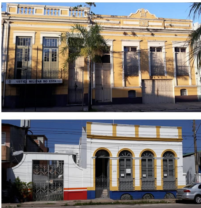
Figura 40: Acima, os prédios pertencentes a Justiça Militar do Estado, localizados na Av. 16 de Novembro e abaixo, o prédio que serviu como sede da Casa da Mulher, na Trav. Bom Jardim. Fonte: Sidney Pery, 2019.
