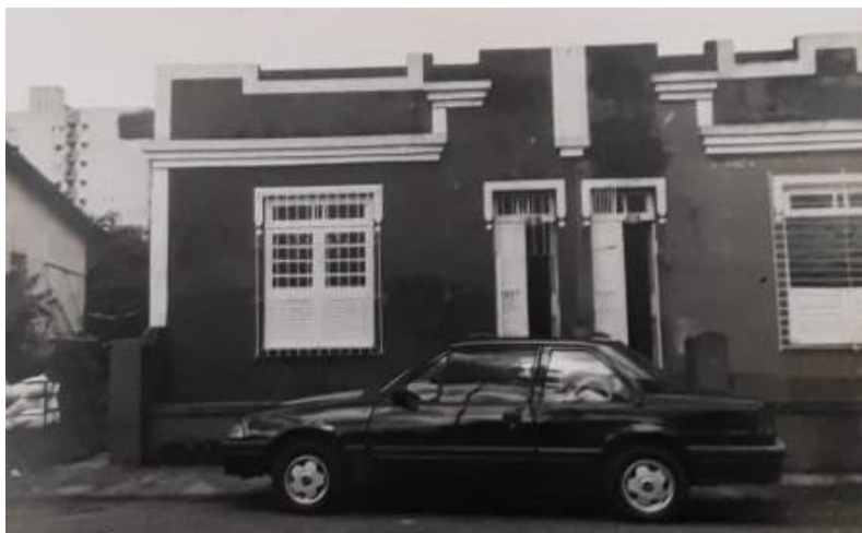
Figura 56: Edificações protomodernas demolidas localizadas na Travessa Bom Jardim. Fonte: Aldine Cavalcante, FUMBEL, 1994.
