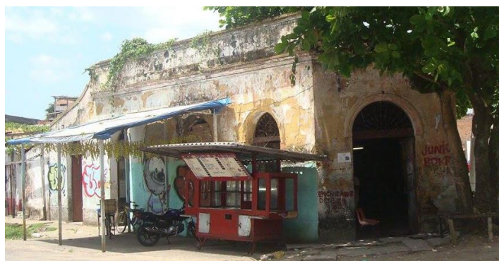
Figura 35: Edificação que atualmente abriga uma borracharia na Rua Cesário Alvim. Fonte: José Vasconcelos, 2015.
