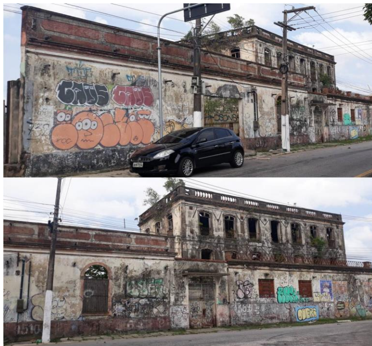
Figura 34: Edificações em estado de abandono localizadas próximo à Praça Carneiro Soares. Fonte: Sidney Pery, 2019.
