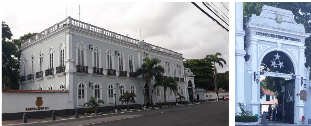
Figura 28: O prédio do 4º Distrito Naval de Belém e os detalhes do portal e do portão em ferro. Fonte: Sidney Pery, 2019.
