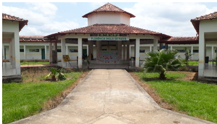
Imagem 2: Atual prédio da escola Florência Inglis de Paiva.
