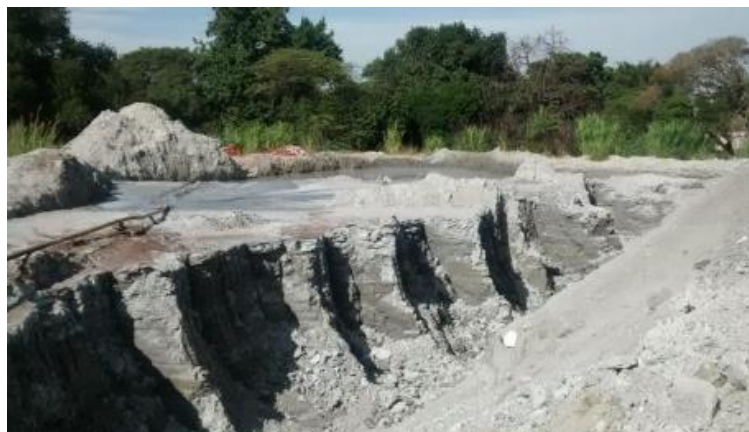
Figura 6. Bacia de decantação dos resíduos gerados do corte de blocos de granito
