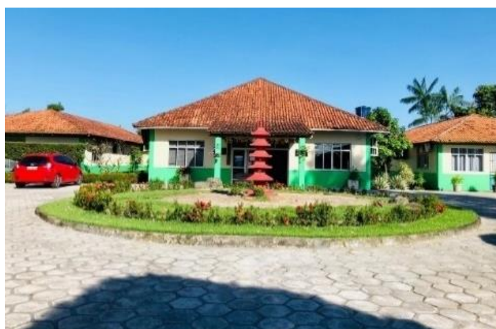
Figura 2: Fachada do bloco principal
