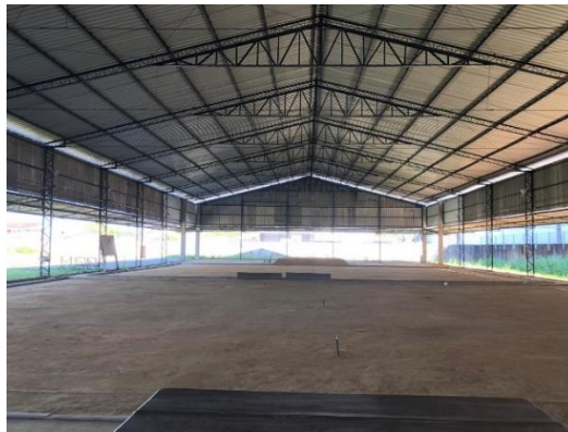
Figura 9: Vista do galpão
