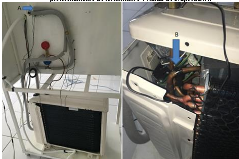
Figura 39. (A) Mudança de posicionamento do termômetro 4 (entrada do evaporador); (B) Mudança de posicionamento do termômetro 4 (saída do evaporador).
