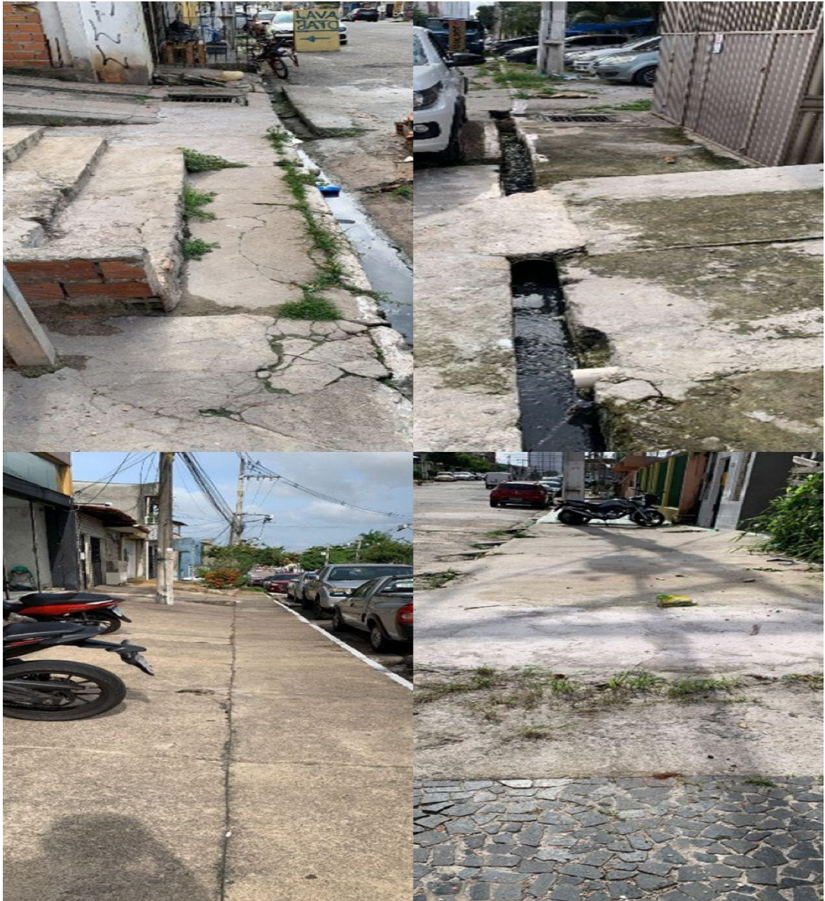
Figura 2: Fotos das calçadas do trecho 2 (entre Rua Nova e Antônio Everdosa)
