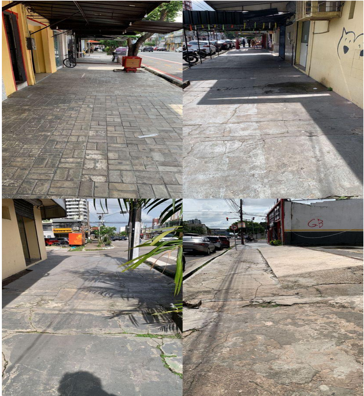
Figura 8: Fotos das calçadas do trecho 8 (entre Av. Rômulo Maiorana e Av. Almirante Barroso)
