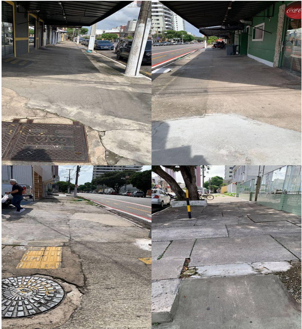
Figura 7: Fotos das calçadas do trecho 7 (entre Av. Duque de Caxias e Av. Rômulo Maiorana)
