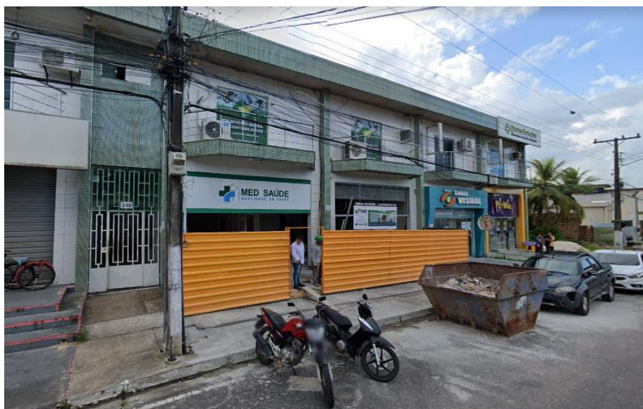
Figura 22 - Vista lateral do local da instalação
