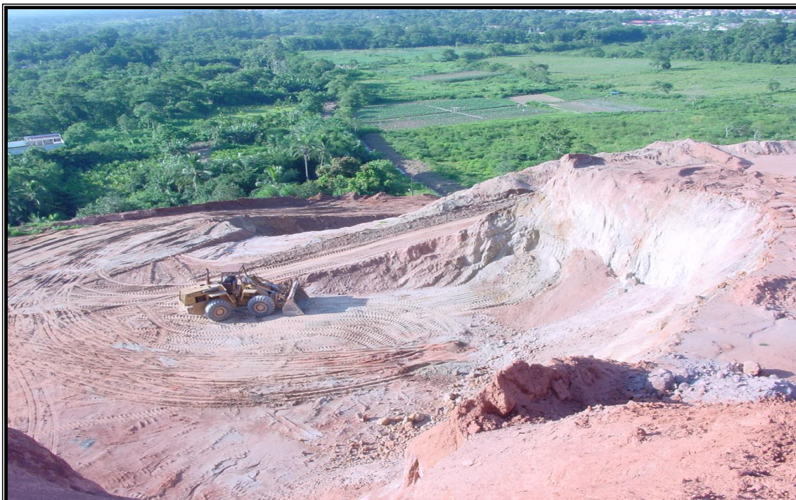
Figura 3 - Lavra por escavação por meio de escavadeiras. Fonte: Bauermeister, 2007
