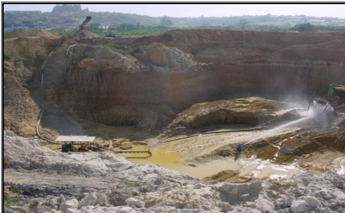
Figura 5 - Desmonte hidráulico. Fonte Bauermeister, 2006.
