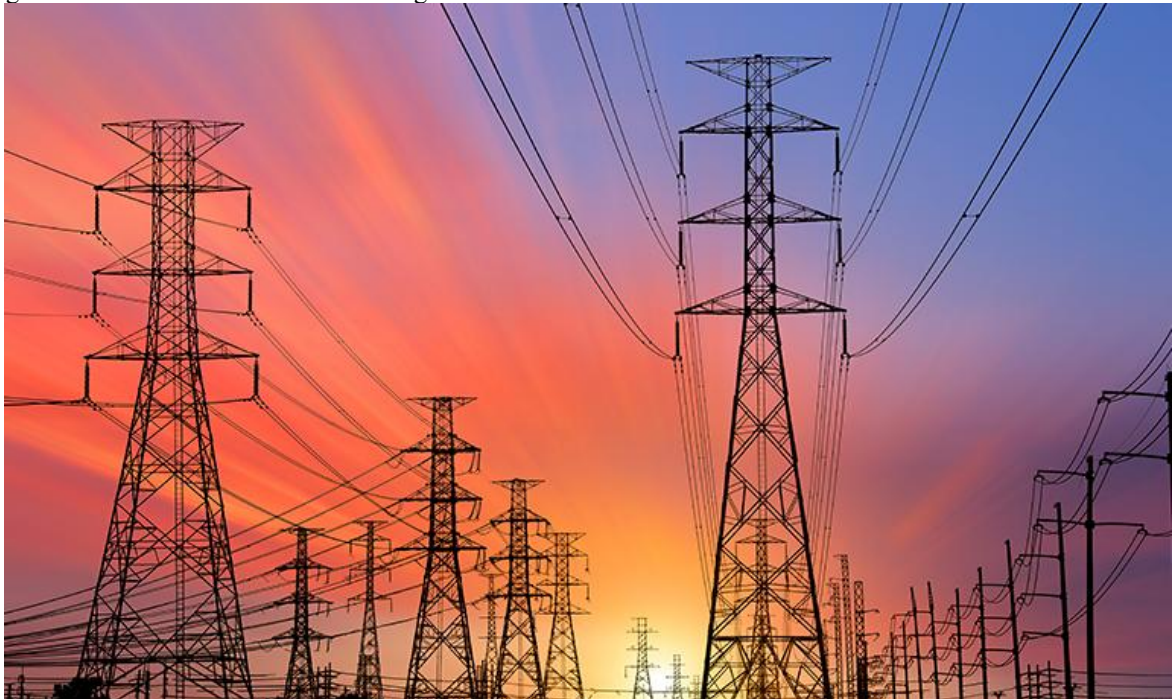
Figura 5 – Redes de transmissão de energia elétrica
