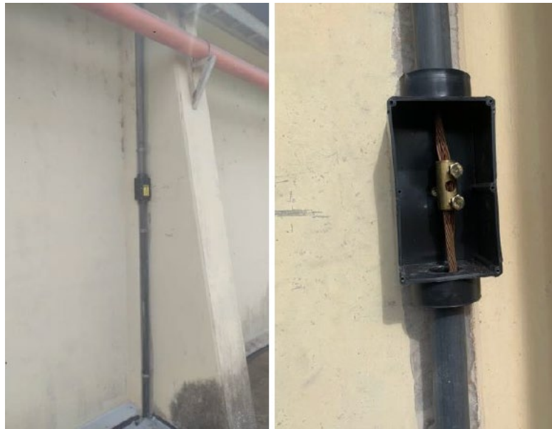
Figura 27 - Caixa de inspeção suspensa - armazém
