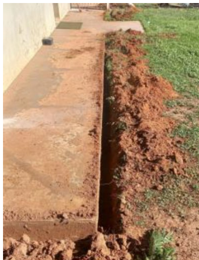
Figura 17 – Valetas para instalação do cabo do anel de aterramento - banheiro motoristas
