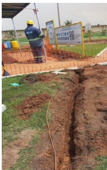
Figura 23 - Valetas para instalação do cabo do anel de aterramento - utilidades
