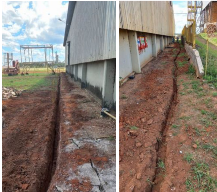
Figura 20 - Valetas para instalação do cabo do anel de aterramento - barracão de resíduos
