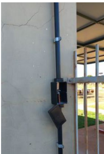
Figura 25 – Caixa de inspeção suspensa - utilidades
