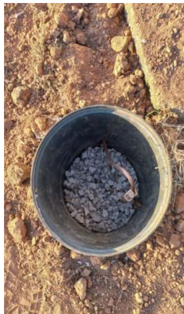
Figura 21 – Caixa de inspeção no solo - barracão de resíduos
