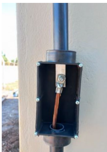
Figura 19 – Caixa de inspeção suspensa - banheiro motoristas
