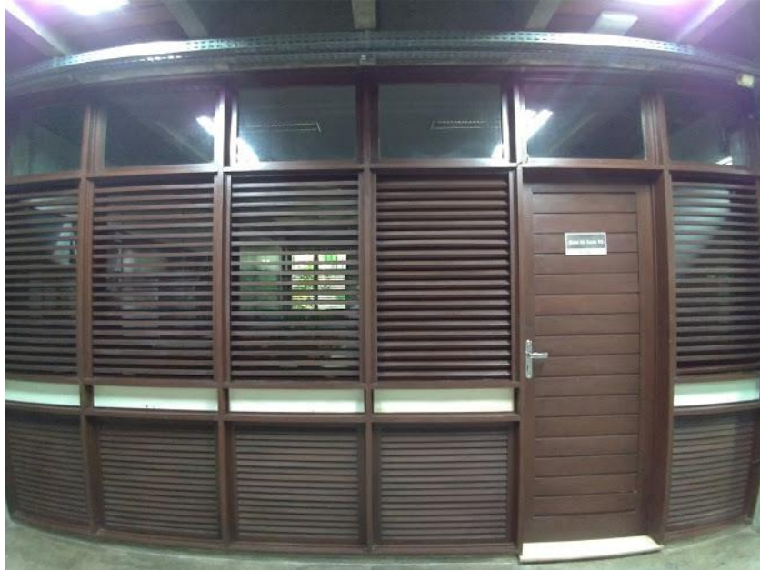
Figura 28: Parede interna da Sala Sul.
