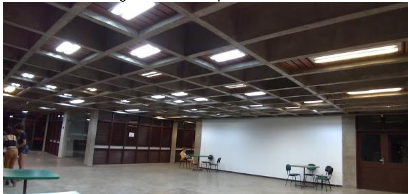
Figura 25: Hall do prédio da FAU.
