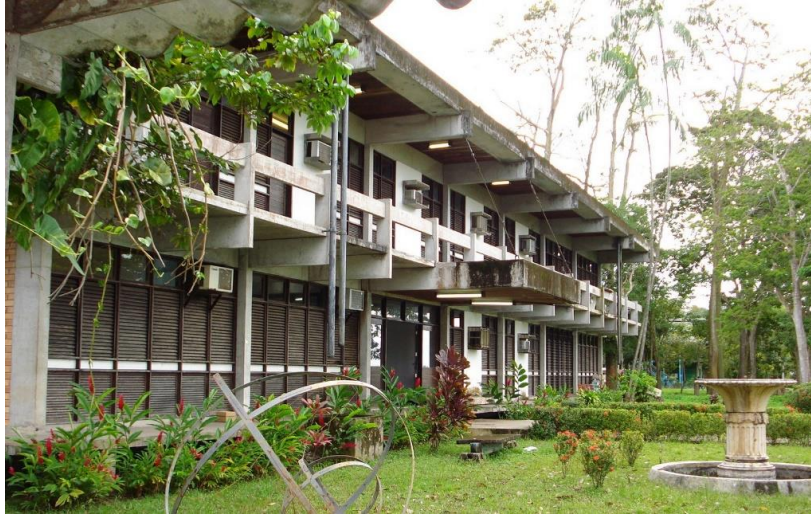
Figura 24: Fachada do prédio da FAU.
