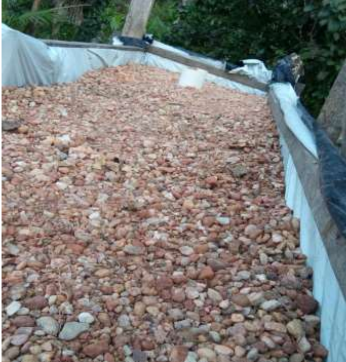
Figura 3. Vista superior da bancada de cultivo do tipo media-filled bed ou ambiente de cultivo em cascalhos, implementada na Unidade de Produção Familiar, em Tauerá de Beja, Abaetetuba, PA.
