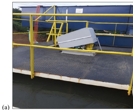
Figura 9 – (a) Floculador Mecânico da ETA – Vila; (b) Representação interna.
