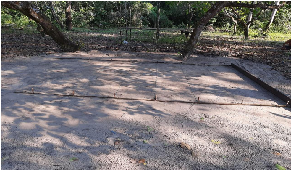
Figura 10 - "Tiá" Estrutura para recebimento das talas
