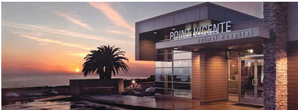
Figura 25: Visão da fachada do Hospital Animal Point Vicent. Fonte: rfarchitects.com
