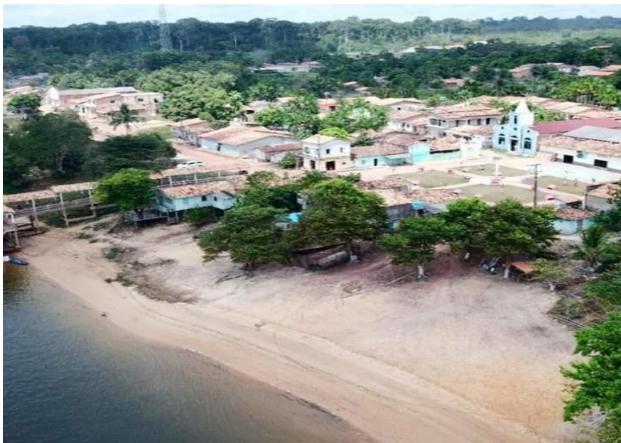
Figura 02 - Comunidade de Umarizal vista de cima
