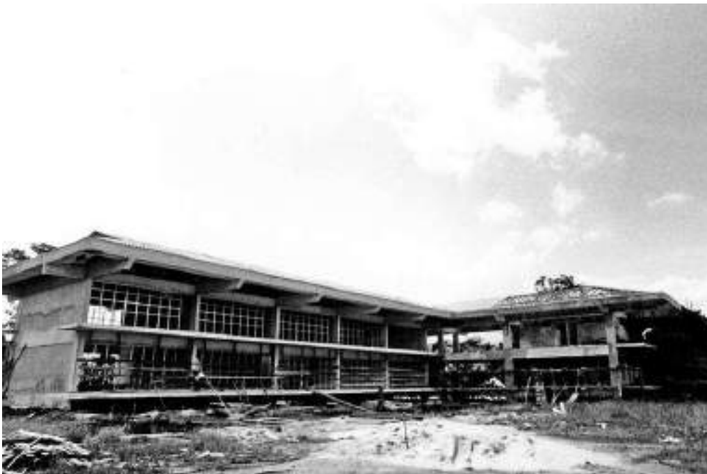
Figura 7 – Construção do prédio da Escola primária, atualmente EAUFPA
