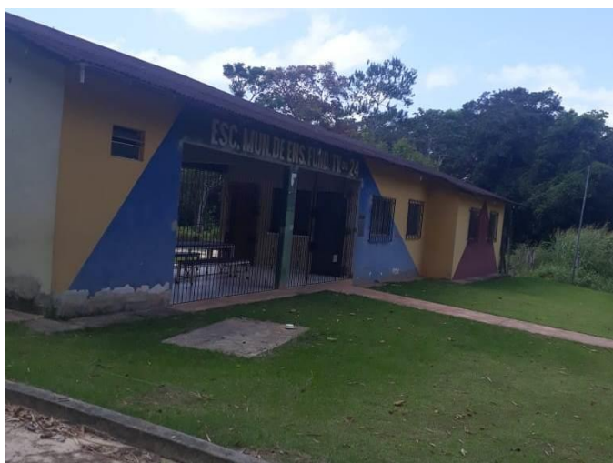
Figura 2: Fachada da escola Municipal Travessa do 24
