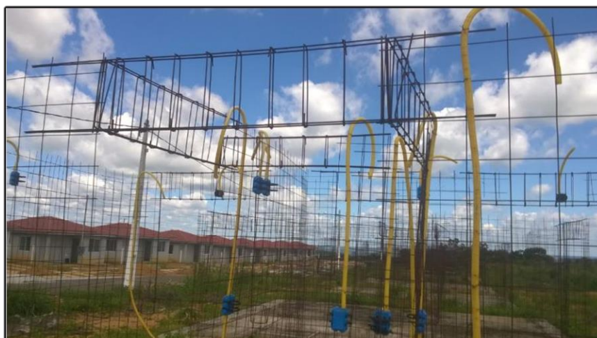
Figura 10 - Armadura de reforço em abertura da parede (Vivacidade Turucuí).
