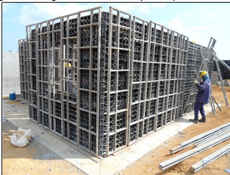
Figura 12 – Montagem de sistema de fôrmas plásticas (Vivacidade Tucuruí).
