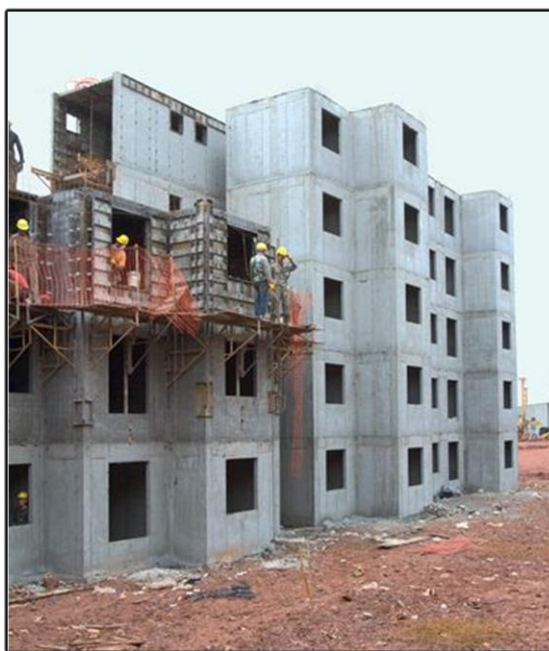
Figura 7 - Construção de edifício de 5 pavimentos em paredes de concreto armado moldadas in loco .
