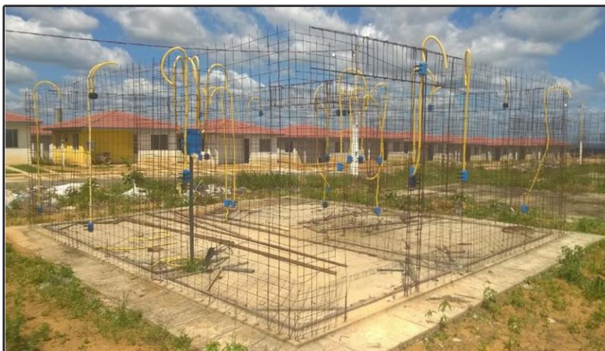
Figura 9 - Montagem das armaduras da estrutura (Vivacidade Tucuruí).
