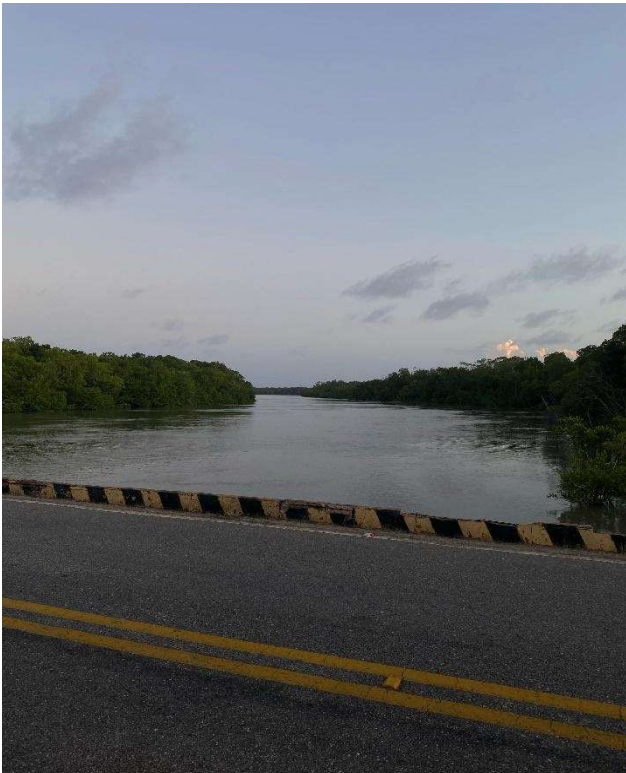
Figura 2 – Ponte sobre o Furo Grande (P3). Fonte: Acervo pessoal.
