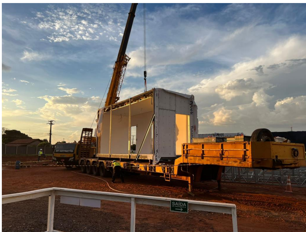
Fotografia 8 - Armazenamento e montagem de módulos
