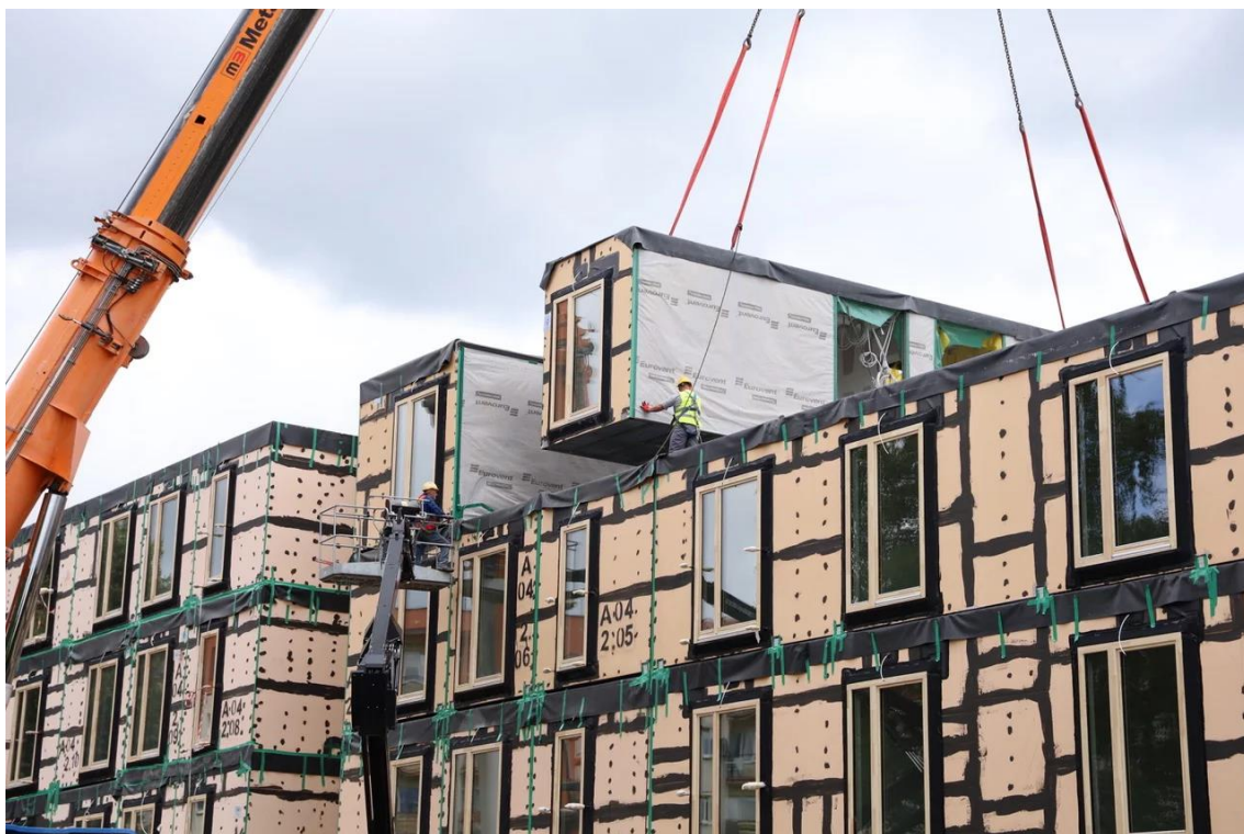
Fotografia 3 - Montagem dos módulos
