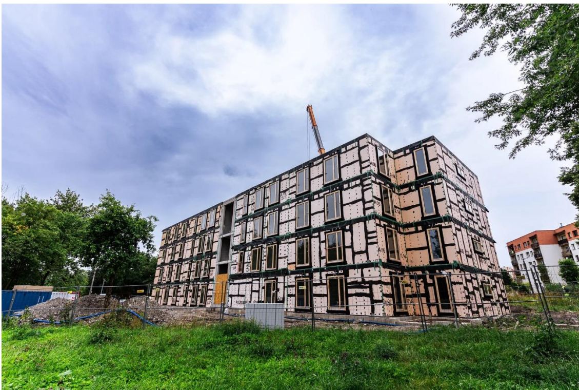
Fotografia 2 - Montagem dos módulos
