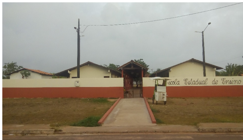
Figura 1: Prédio da escola pesquisada
