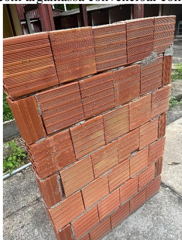
Figura 26 - Parede construída com argamassa convencional com juntas sem degradação
