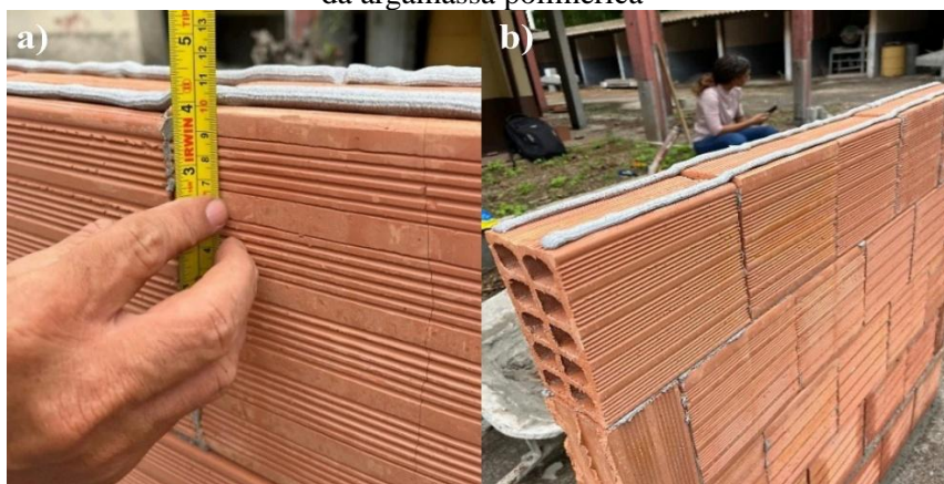
Figura 20 - Construção de protótipo: a) medição da espessura da junta e b) aplicação da junta horizontal da argamassa polimérica
