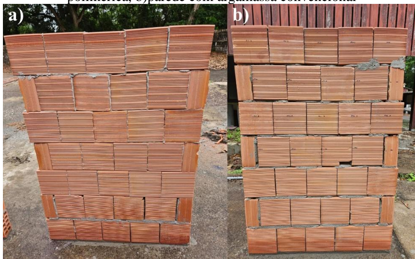
Figura 29 - Umidade superficial na região inferior e superior das paredes: a) parede com argamassa polimérica, b) parede com argamassa convencional
