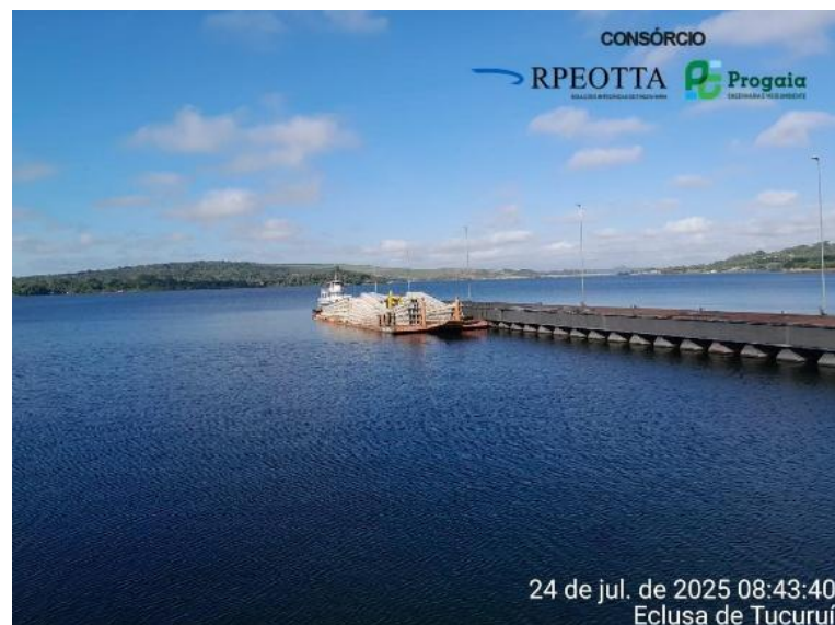
Figura 46 - Chegada do comboio ao muro guia flutuante (montante) - Eclusa 1
