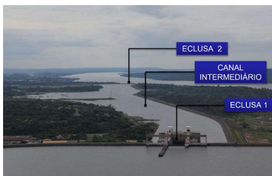
Figura 37 - Vista de montante para jusante
