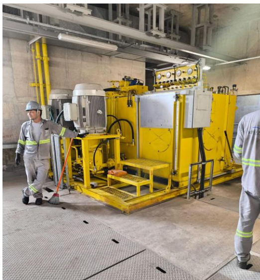
Figura 12 - Central hidráulica
