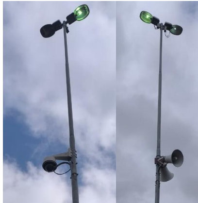
Figura 27 - Sistema de CFTV e Alta Voz
