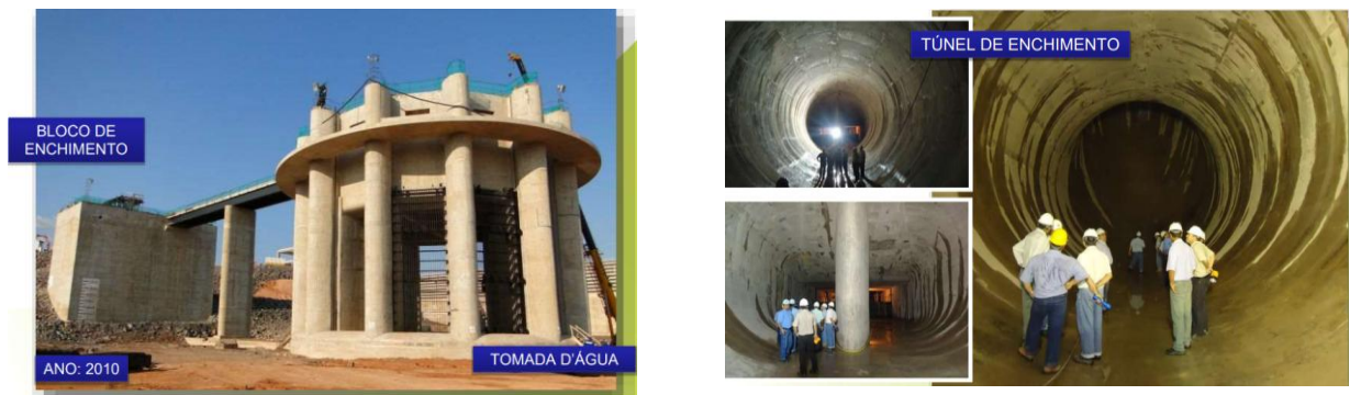
Figura 16 - Estrutura da comporta de enchimento da Eclusa 2
