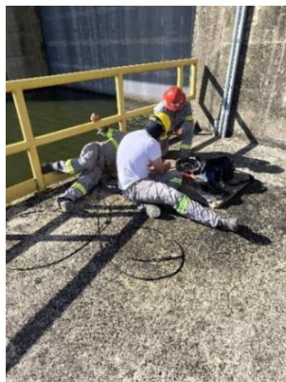
Figura 35 - Verificação da sonda de nível
