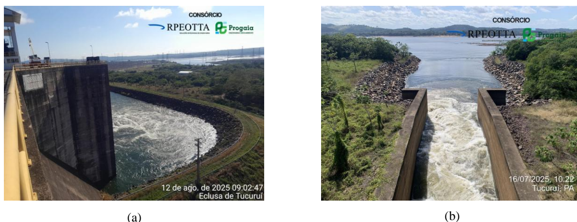
Figura 23 - Esvaziamento da câmara principal da Eclusa 1 e 2
