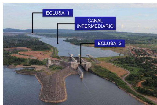
Figura 38 - Vista de jusante para montante
