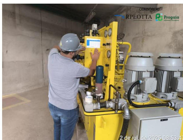
Figura 17 - Central hidráulica
