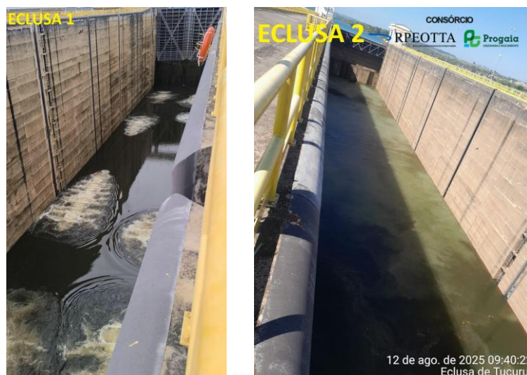
Figura 19 - Enchimento da câmara principal da Eclusa 1 e 2
