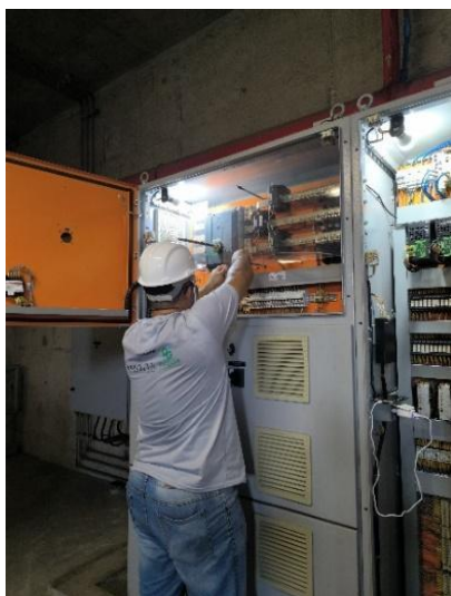
Figura 34 - Substituição de componente
