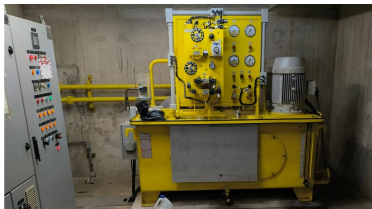
Figura 22 - Central hidráulica
