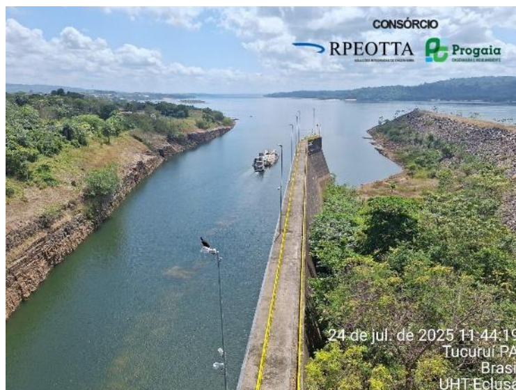
Figura 52 - Saída do comboio da câmara principal e término da transposição - Eclusa 2
