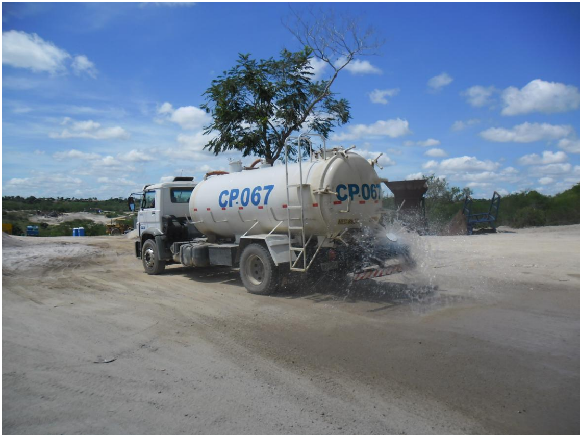
Figura 17. Caminhão pipa umedecendo as vias de acesso.
