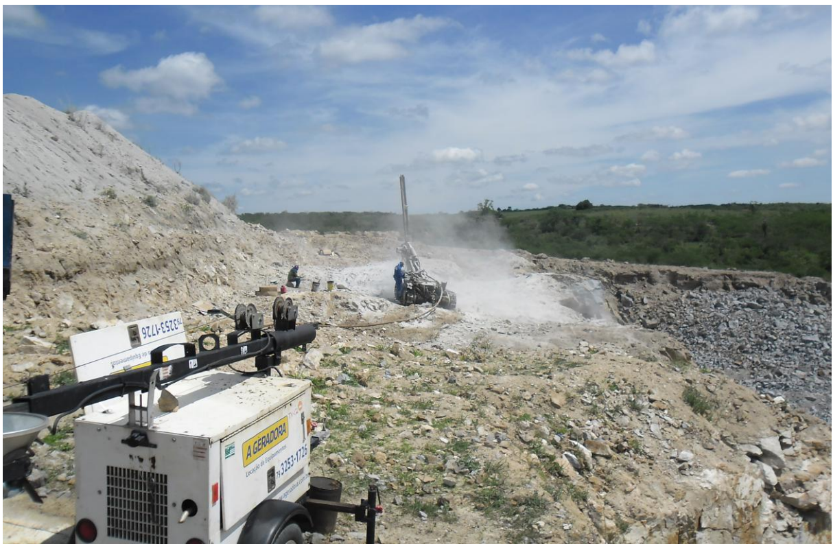
Figura 15. Perfuratriz trabalhando na execução dos furos para preparação do plano de fogo.
