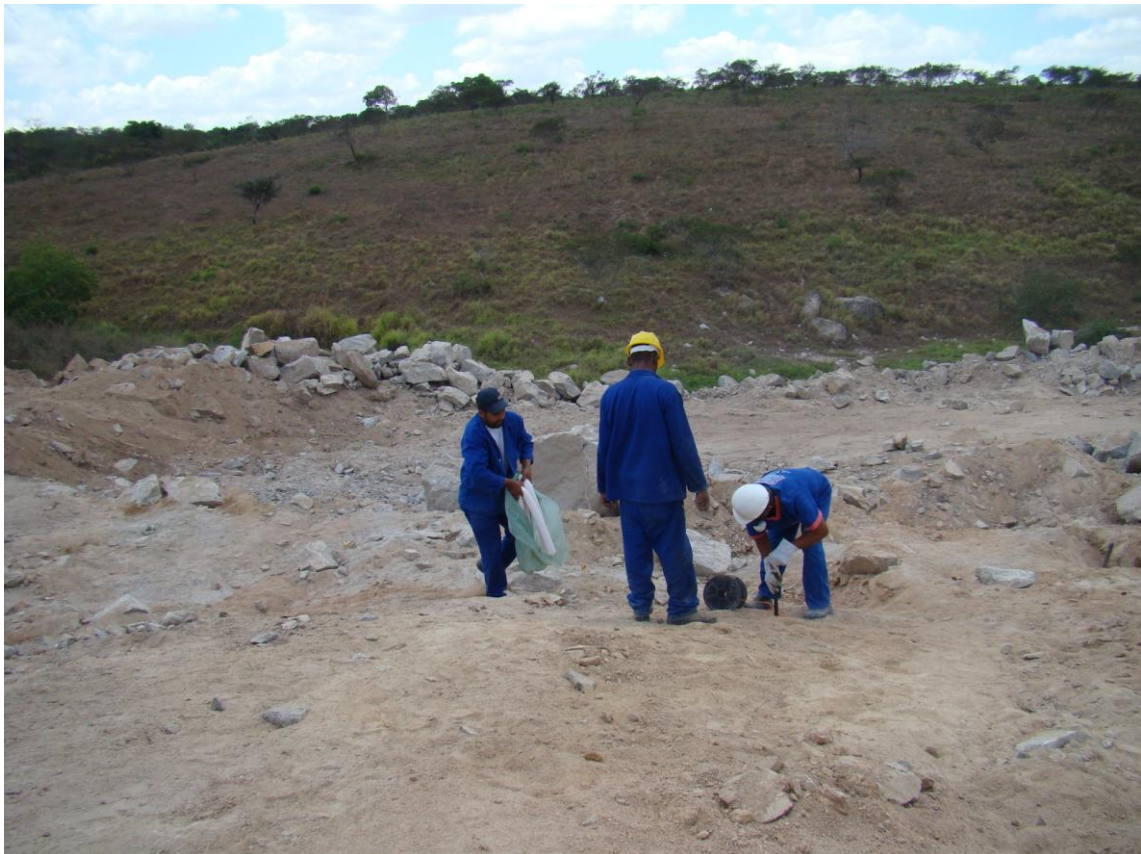
Figura 13. Equipe colocando as dinamites nos furos para detonação.
