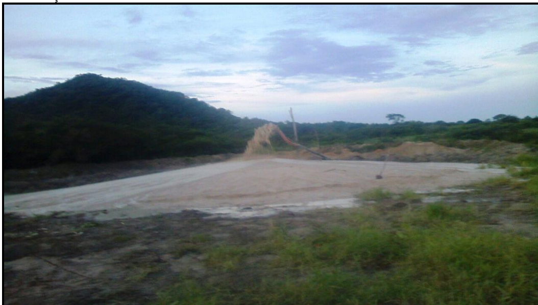
Figura 16 - Lançamento da areia no porto de descarrego que não contém barreira de contenção
