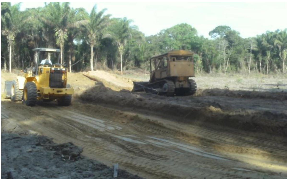
Figura 4 - Implantação de nova área do lixão do Recreio - Baião / PA.
