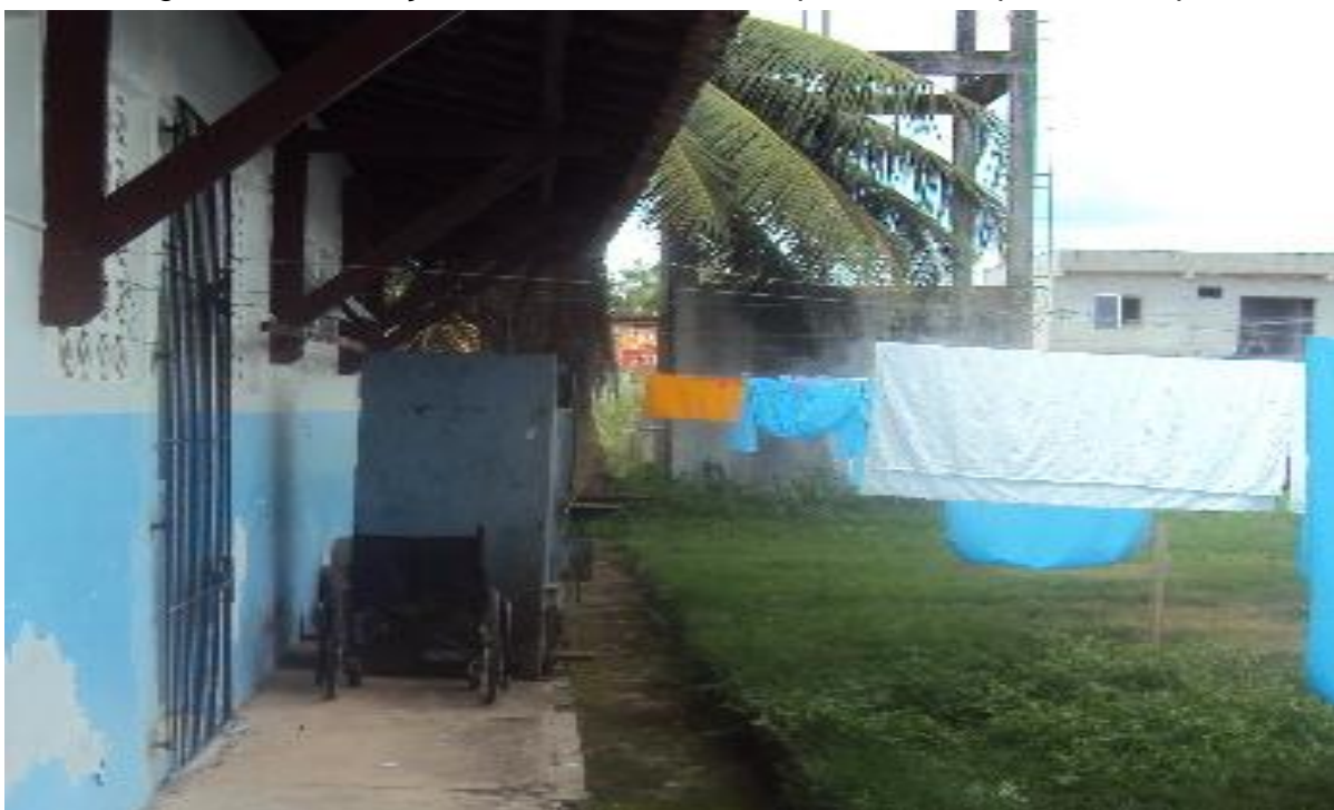
Figura 6 - Presença de um Incinerador no pátio do Hospital Municipal
