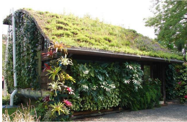
Figura 7 – Sede do Ecotelhado em POA - RS.
