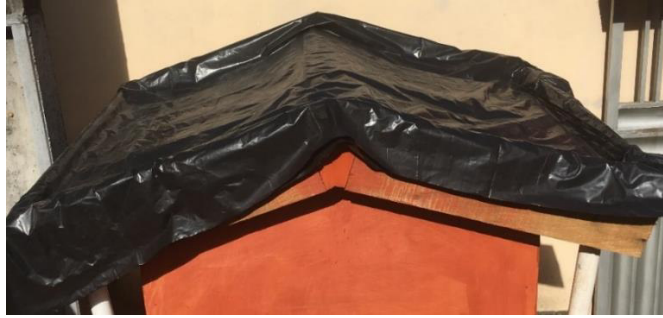
Figura 29 – Segunda camada impermeabilizante de lona.
