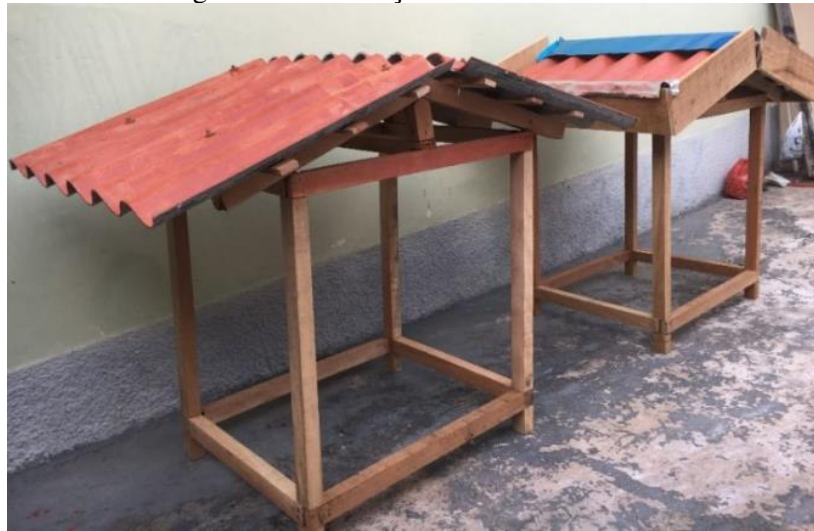
Figura 26 – Colocação das telhas e calhas.
