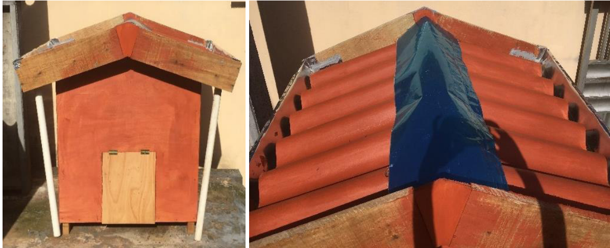
Figura 28 – Impermeabilização do telhado e paredes.
