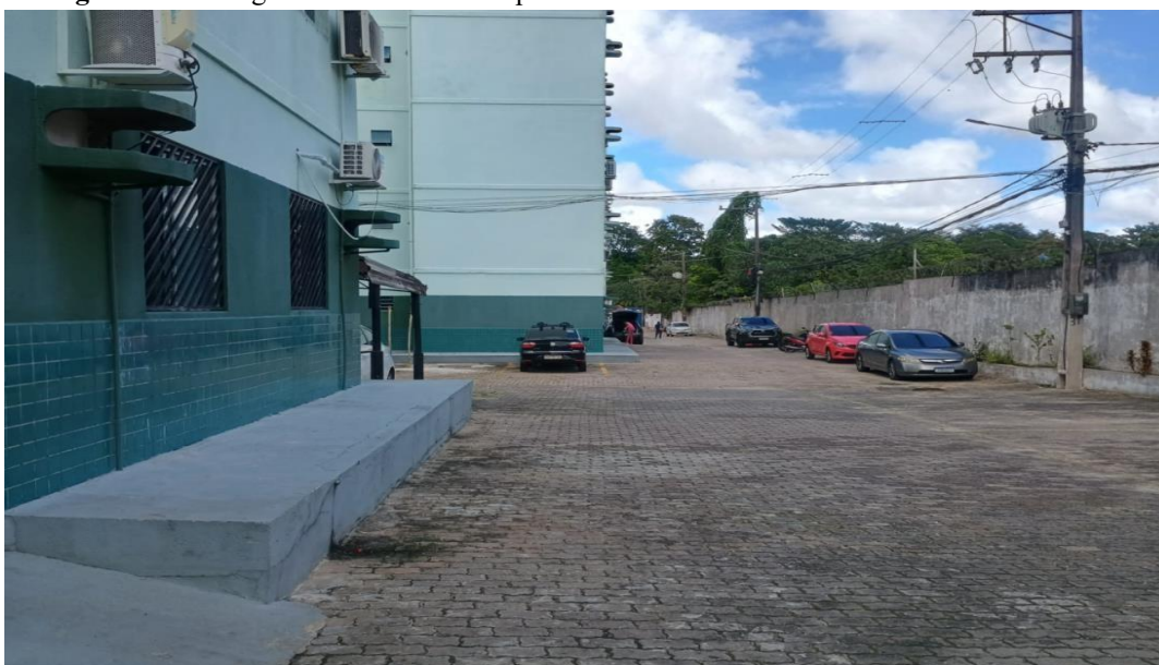
Figura 9 – Vista geral das vias internas pavimentadas com blocos intertravados de concreto.
