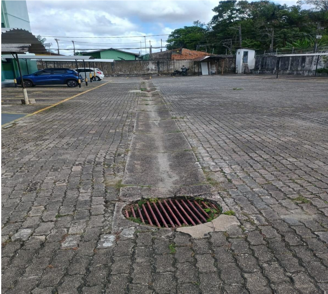
Figura 14 – Vista geral do sistema de drenagem superficial longitudinal em área de estacionamento.
