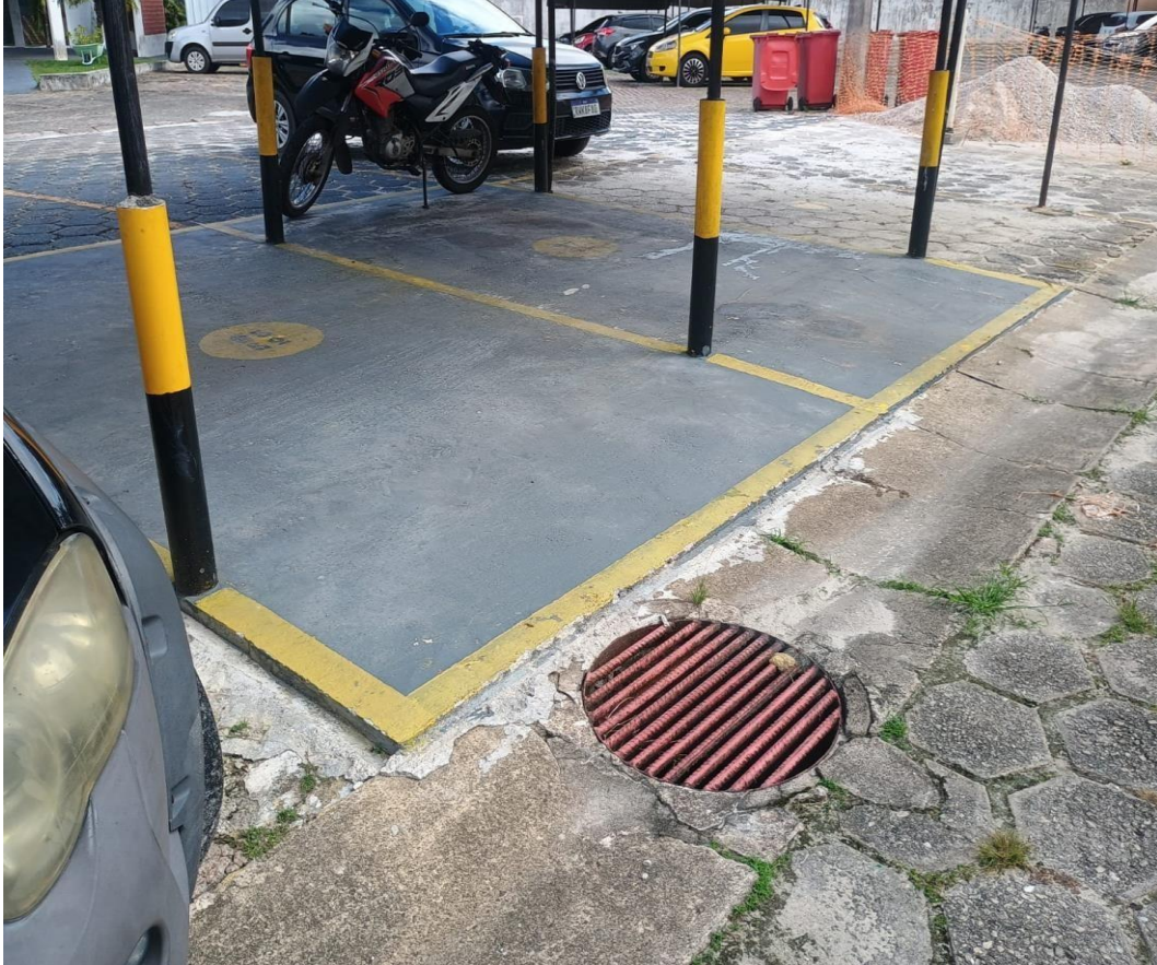
Figura 10 – Substituição do pavimento intertravado por pavimento rígido em área de estacionamento.
