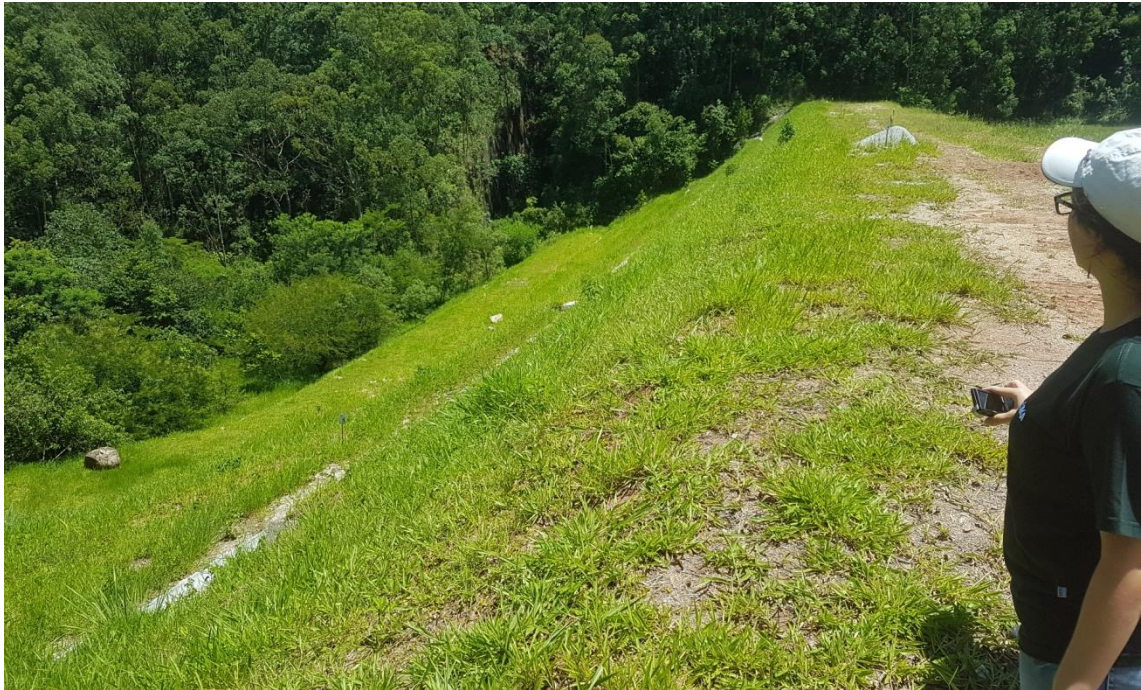
Figura 15 - Não existem deformações, recalques e nem sinais de deterioração nos taludes.
