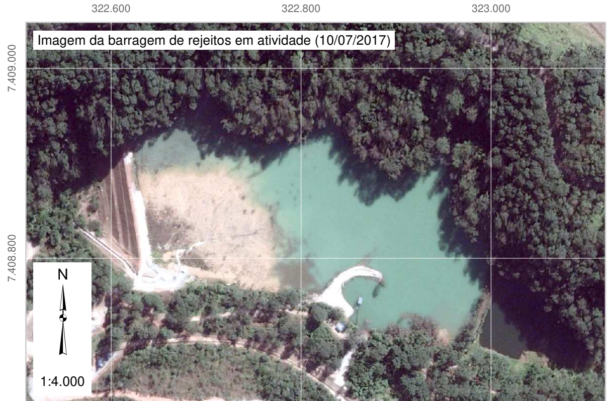
Figura 8 - Barragem de rejeitos da Territorial São Paulo em plena atividade (10/07/2017) e em processo de descomissionamento (23/08/2020)
