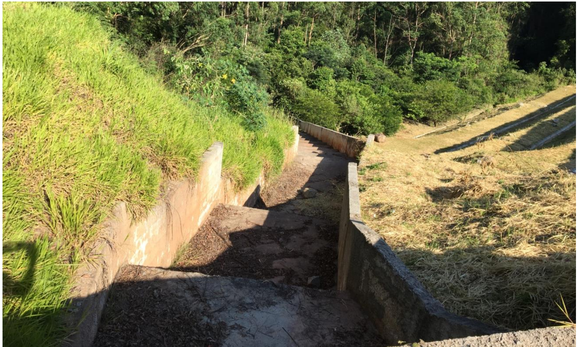
Figura 14 - Escada hidráulica ligada a sistema extravasor em excelentes condições
