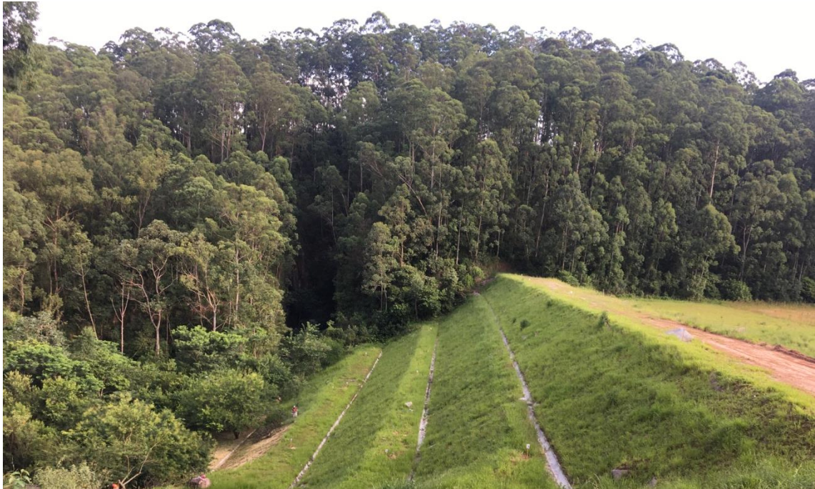
Figura 10 - Vista geral da barragem construída por alteamento a jusante, com crista de 25 metros de altura
