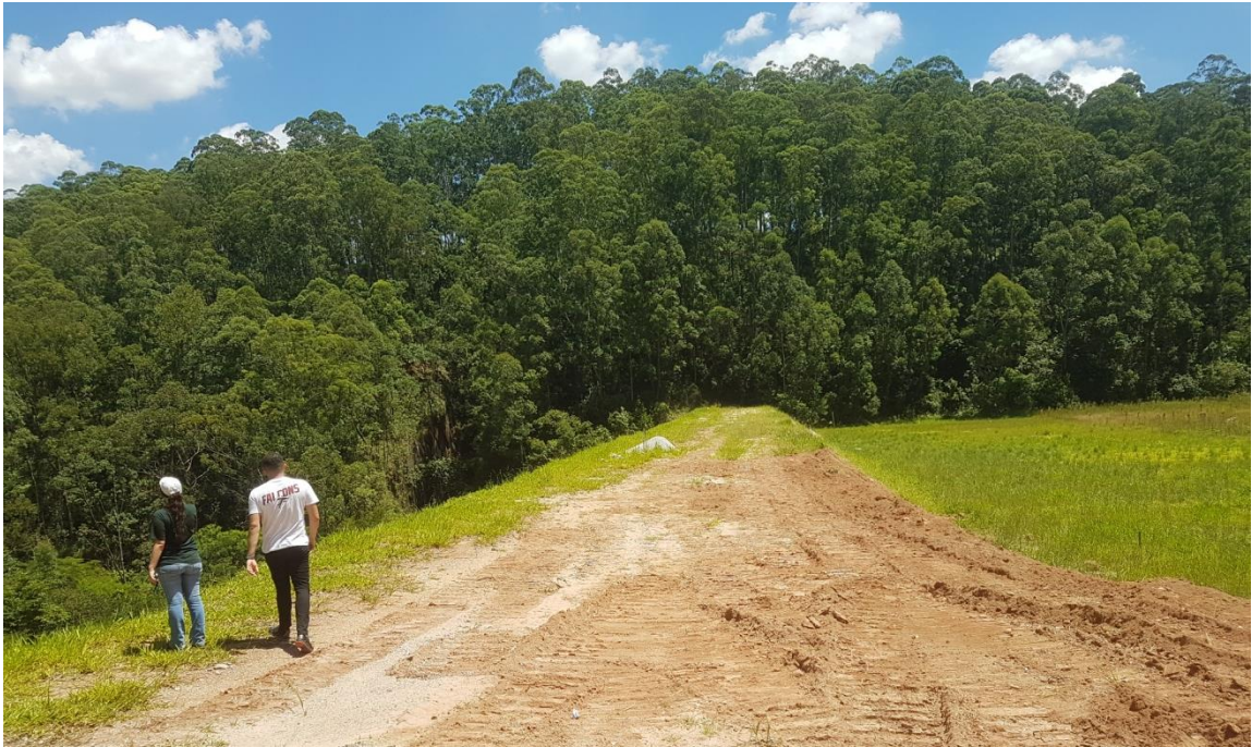
Figura 9 - Crista do barramento, com 160 metros de extensão.
