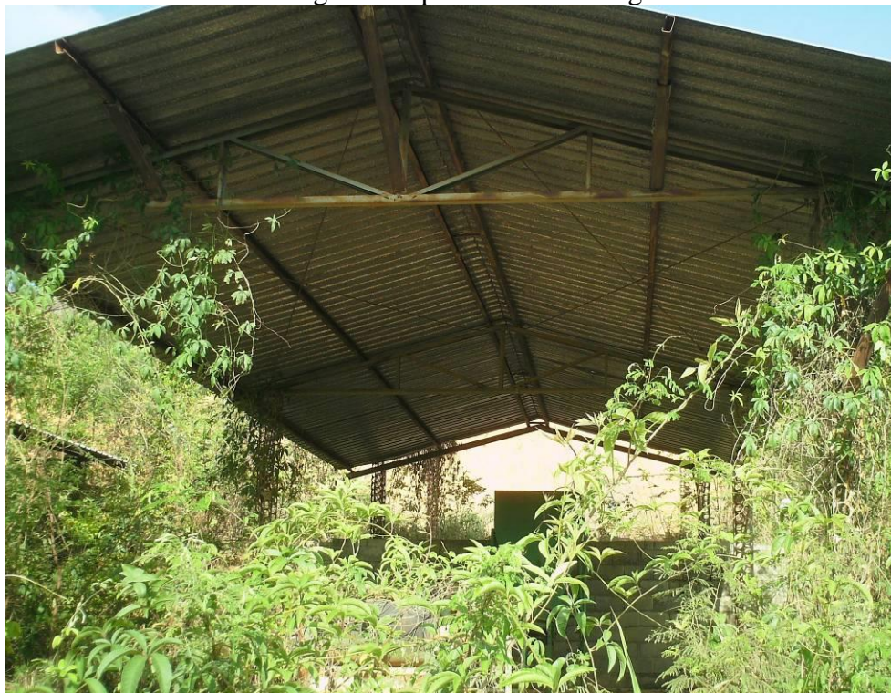
Anexo VII - Usina de Triagem: Galpão esteira de triagem
