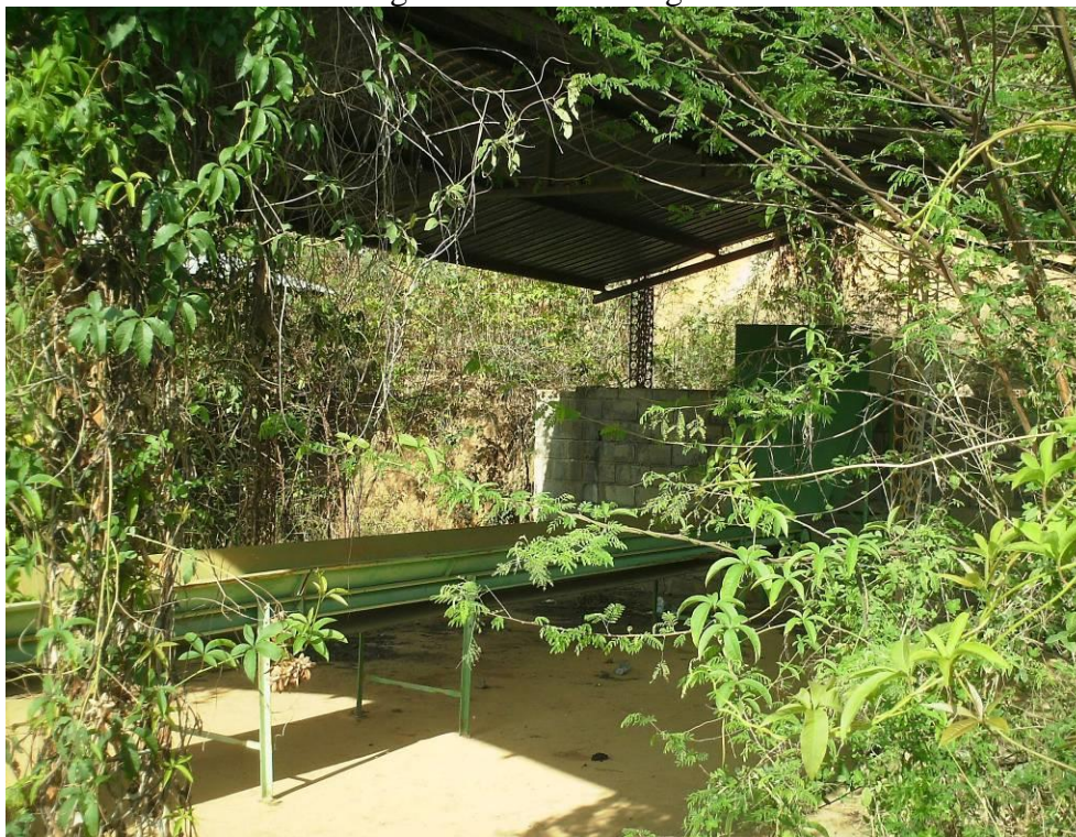
Anexo VIII - Usina de Triagem: Esteira de triagem
