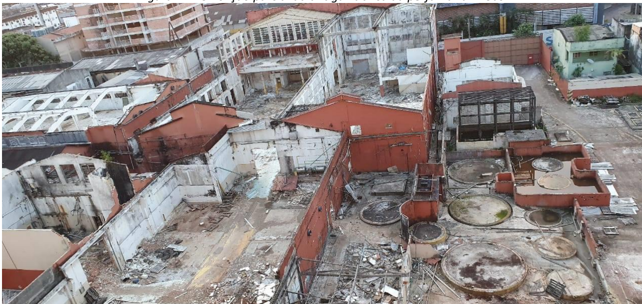
Figura 1 - Demolição parcial da antiga Fábrica da perfumaria Phebo.
