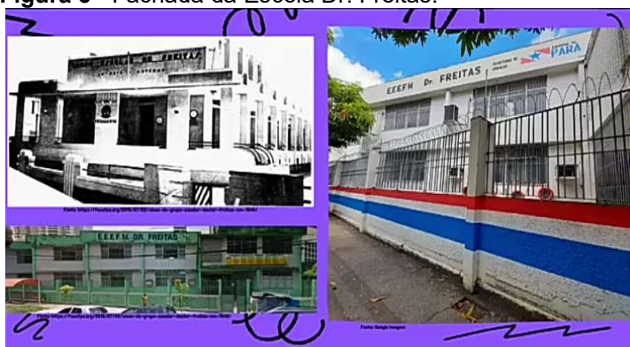
Figura 5 - Fachada da Escola Dr. Freitas.
