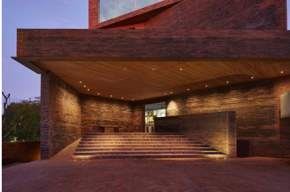
Figura1: Fachada - Hotel Katamama - Bali, Indonésia, Fonte: http://www.archdaily.com.br
