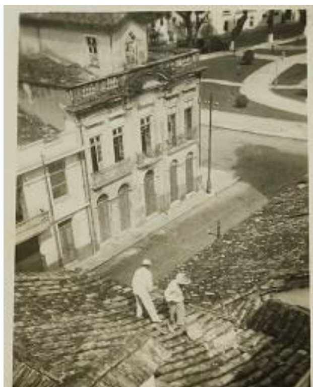
Figura 15: Vsta da edificação do telhado da Catedral da Sé
