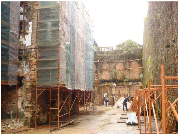
Figura 4: Imagem interna do SESC Boulevard durante a obra de intervenção.
