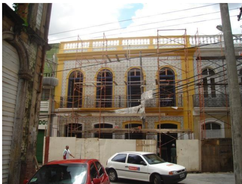
Figura 6: Imagem da fachada do SESC Boulevard durante as obras de intervenção.
