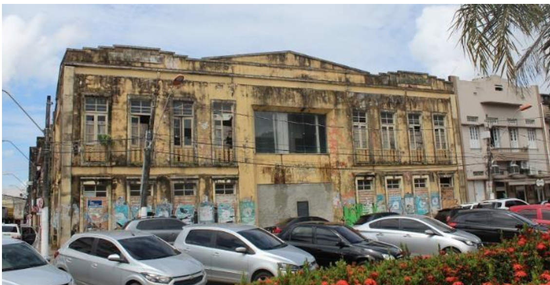
Figura 18: Imagem da fachada da edificação em seu estado atual.
