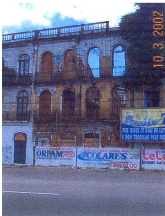
Figura 3: Imagem da fachada do SESC Boulevard antes da intervenção.
