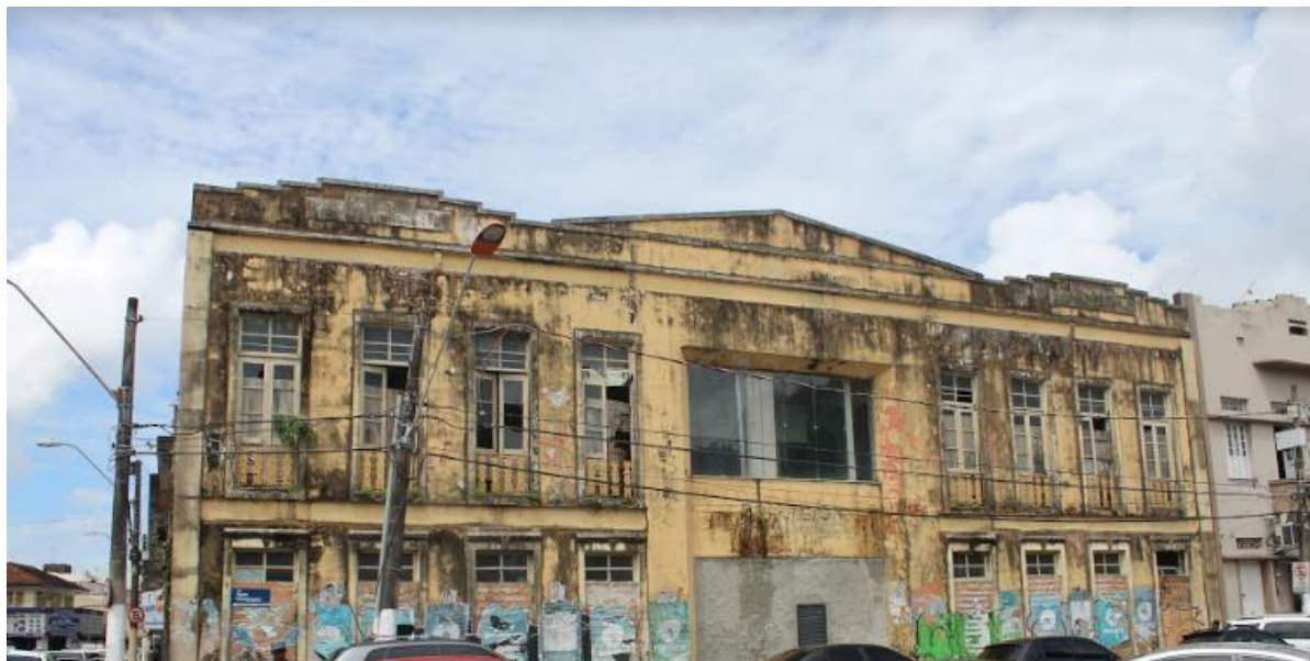
Figura 1: Imagem da fachada da edificação em seu estado atual.
