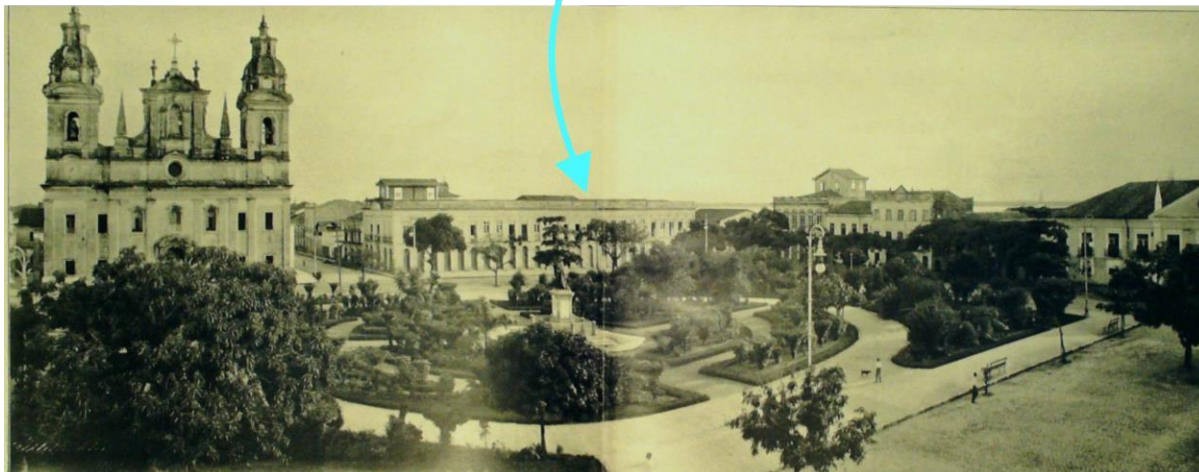
Figura 12: Imagem da Praça Frei Caetano Brandão no início do século XX na qual é possível perceber a praça em primeiro plano, a Catedral da Belém em destaque à esquerda e, ao lado, a edificação no lote objeto de trabalho destacada.
