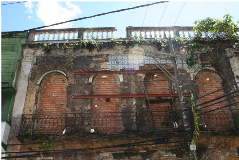
Figura 7: Imagem da fachada do SESC Boulevard antes da intervenção.
