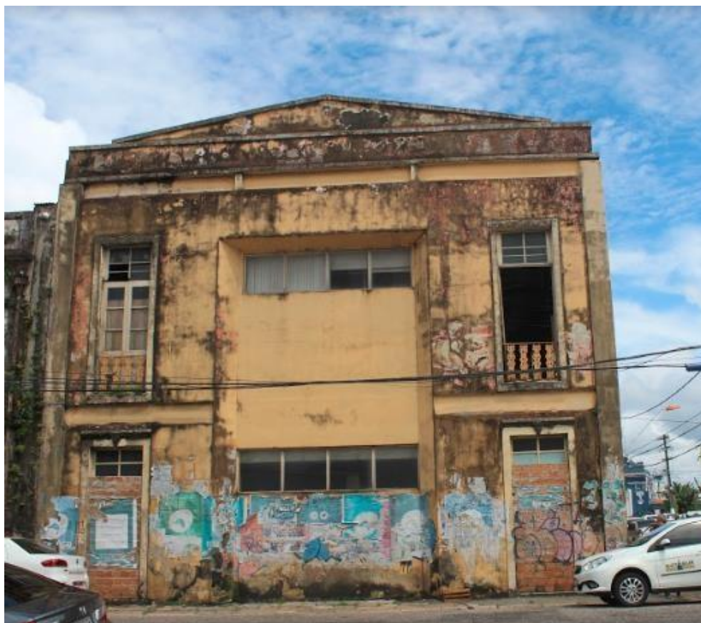
Figura 27: Fachada lateral da edificação.
