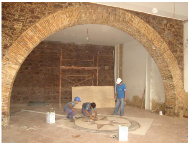
Figura 5: Imagem interna do SESC Boulevard durante a obra de intervenção.
